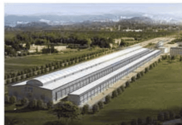
成都高铁动车检修库(U 型中空板系统)
