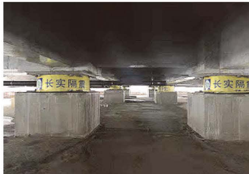
建筑隔震橡胶支座安装完成实景图
