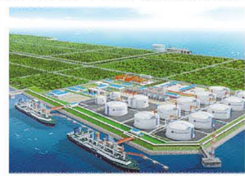
天津中石化LNG项目
