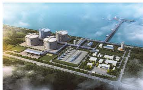
江苏国信液化天然气 LNG储运调峰工程项目
