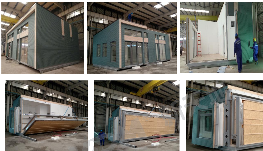
图5 装配式模块化折叠集成房屋折叠过程
