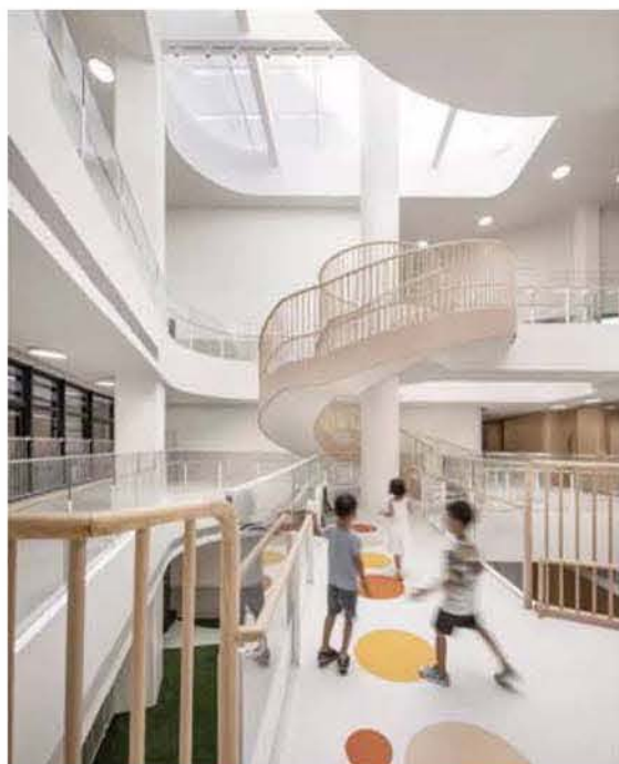
托幼楼梯和平台栏杆
