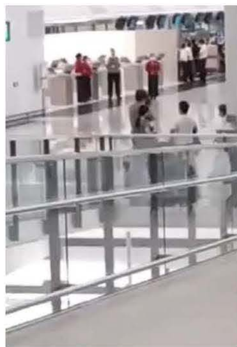
机场候机楼防撞栏杆
