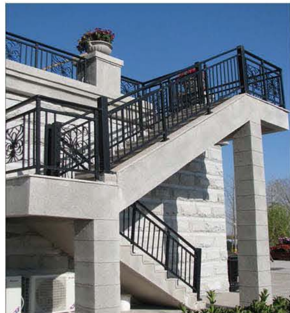
室外楼梯栏杆
