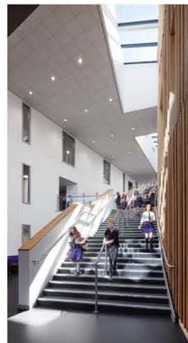
学校宽楼梯中间栏杆
